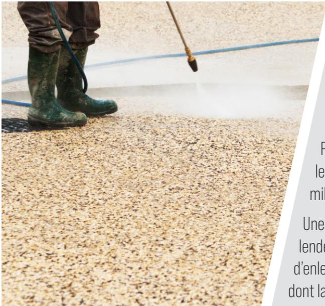
Le **béton désactivé**, également appelé **béton lavé**, est un **béton décoratif** obtenu en alliant une formule de béton adaptée enrichie en gravillons et une technique de coulage de béton particulière.
